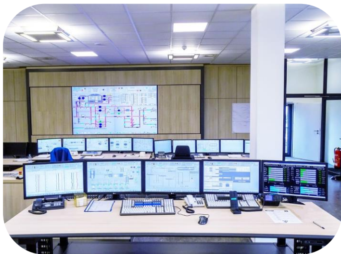
Рабочее место в диспетчерской с многофункциональной клавиатурой MK06
