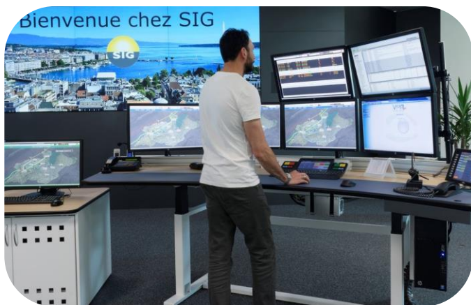
Экран из видеокубов обратной проекции, работающий в непрерывном режиме. На переднем плане – многофункциональная клавиатура WEYTEC Smart Touch
